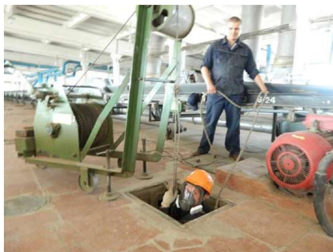
Рисунок 6. Очистка силоса от остатков зерна после ликвидации пожара рабочими предприятия
